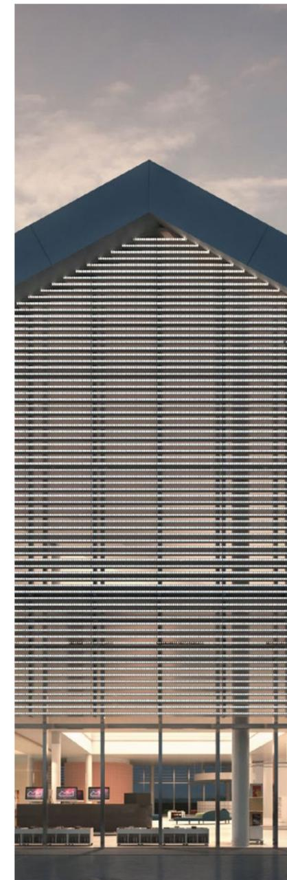
Due immagini del sistema di strisce LED per esterni integrate nei frangisole utilizzato in una realizzazione in Germania. Da vicino si nota il passo tra le strisce e l'effetto di bassa risoluzione. A distanza si percepisce l'immagine nella sua totalità.
